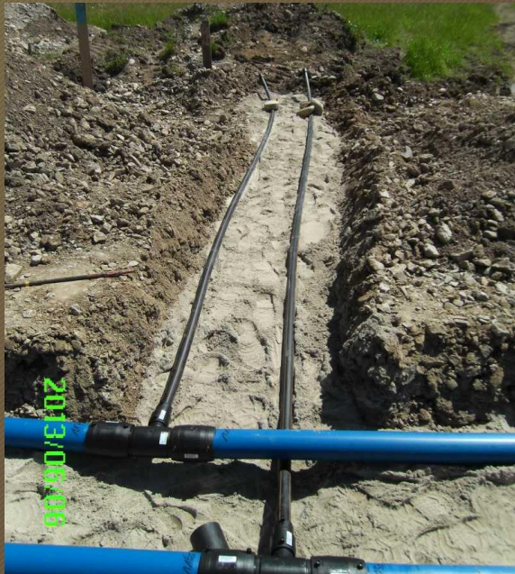
Ein vorbereiteter Hausanschluss
