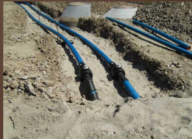
Für einen besseren geothermischen Energiefluss ins Netz werden die Leitungsrohre im Sand verlegt
