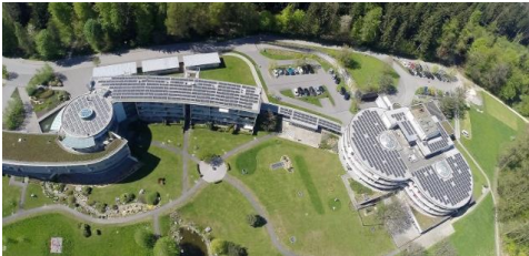
Seniorenresidenz PV vorbereitet 250kWp
